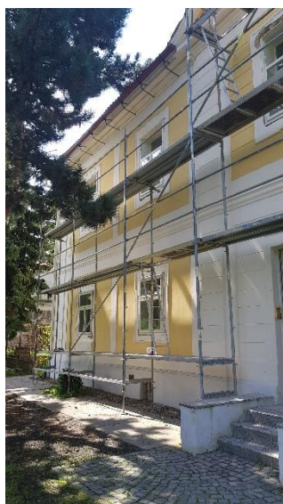
výměna oken Zámeček
