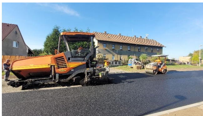
pokládka asfaltu ul. U Cukrovaru
