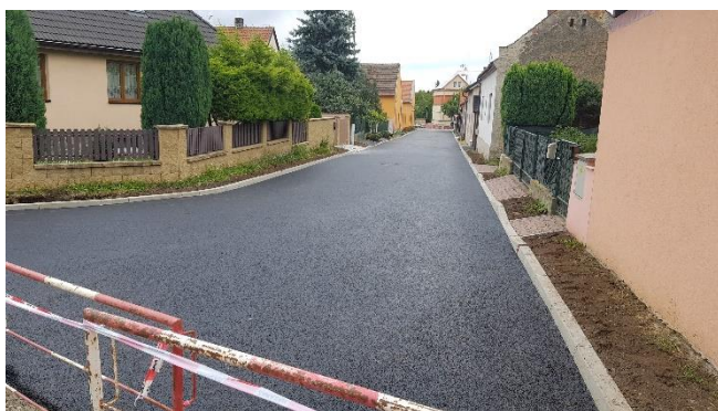
hotový asfalt ul. Spojovací
