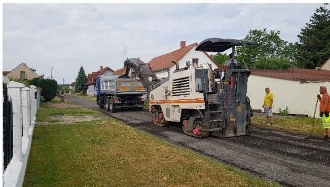
frézování starého asfaltu ul. Sokolská
